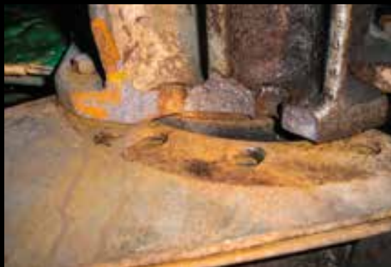
Fot. 1. Korozja obudowy mostu ciągnika
