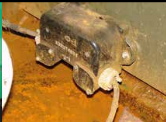
Fot. 6. Korozja we wnętrzu pojazdu
