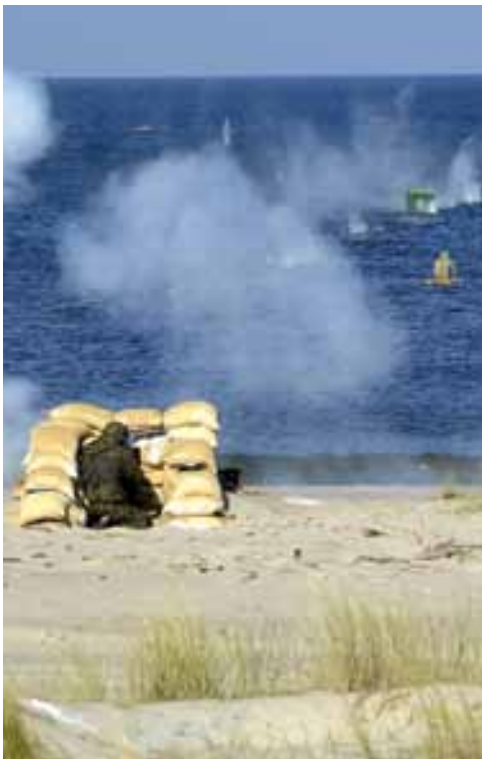
STANOWISKO OGNIOWE wykonane metodą nasypową
