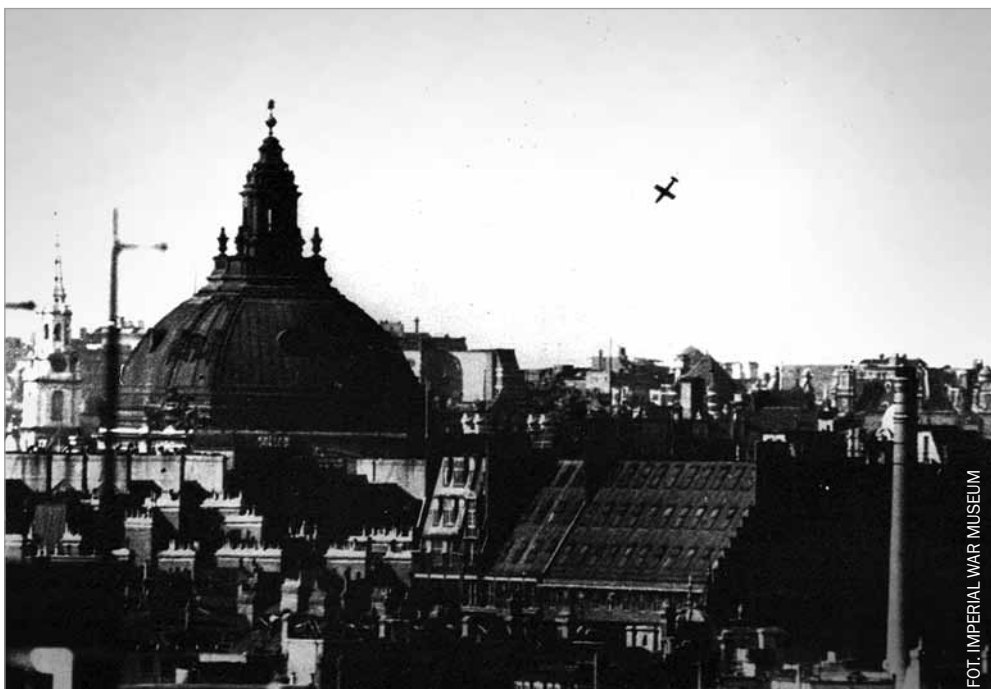
FOT. 1. RAKIETA V-1 nad dachami Londynu
