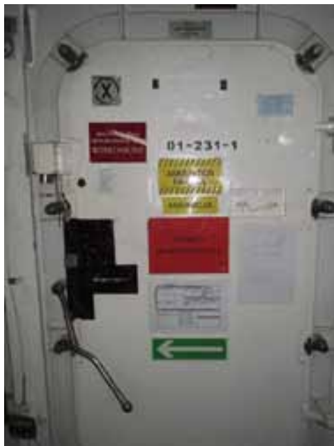
FOT. 2. WŁAZ WEJŚCIOWY
