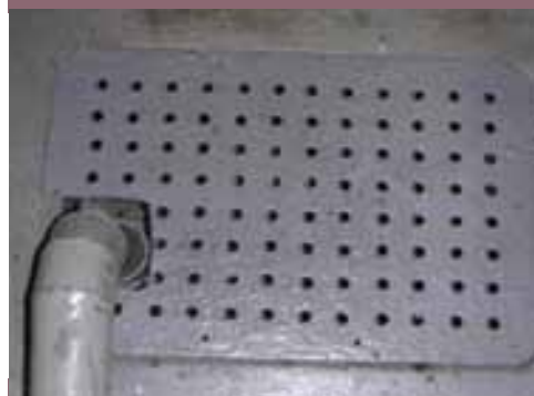
FOT. 5. SYSTEM odwadniania komory
